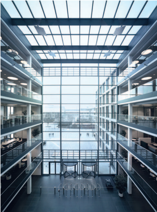
Das Gebäude am Raiffeisenplatz 2 von innen ...
