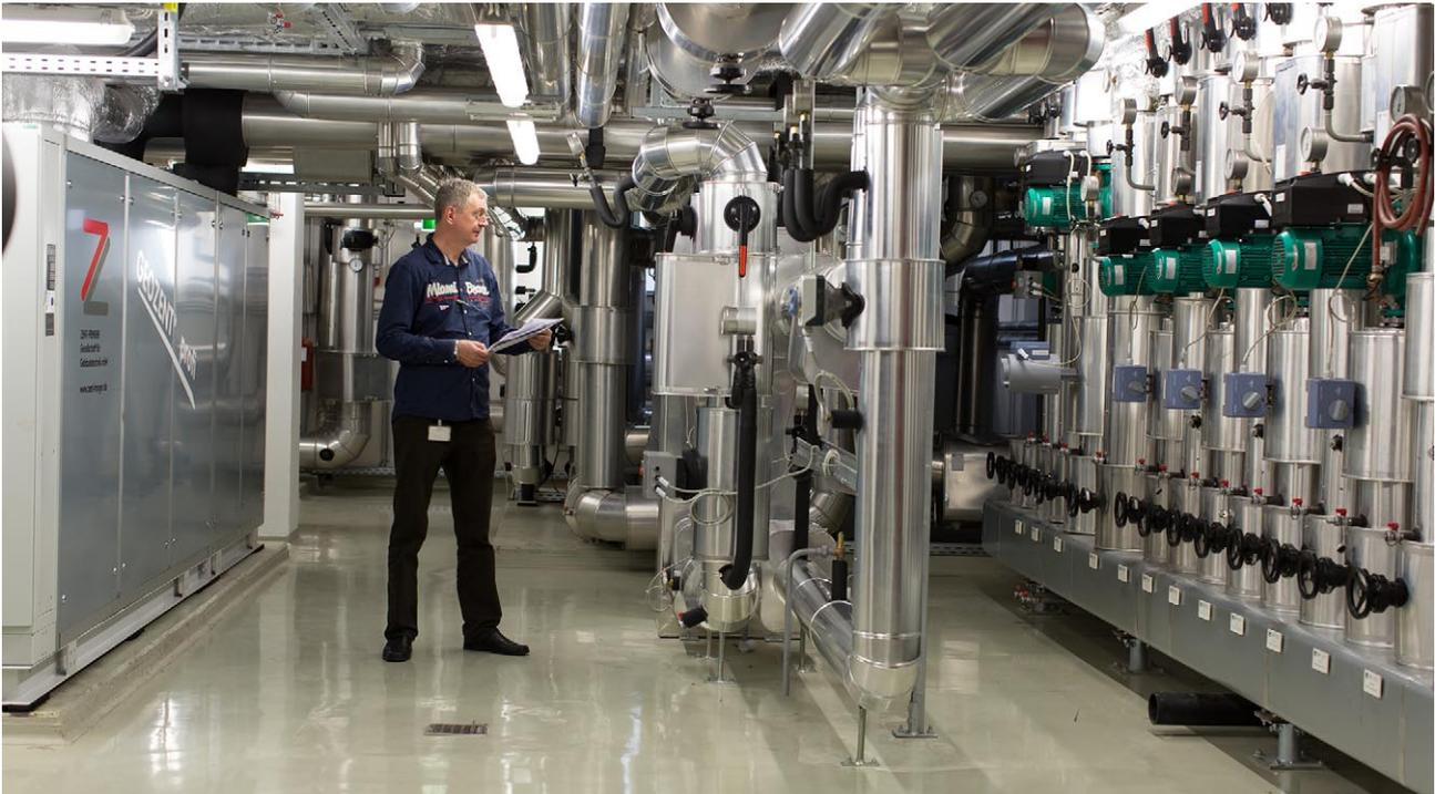
Die Geothermieranlage versorgt das Wiesbadener R+V-Bürogebäude mit Wärme und Kälte.
